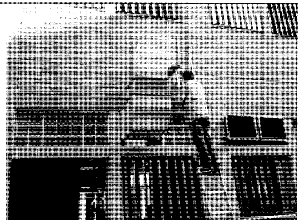
補風及油煙清淨系統風管配置
