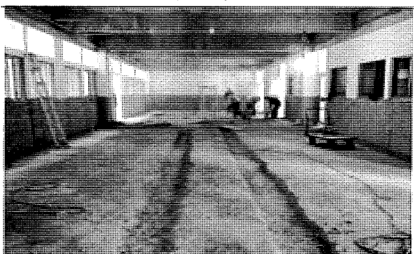
排水管溝挖設
