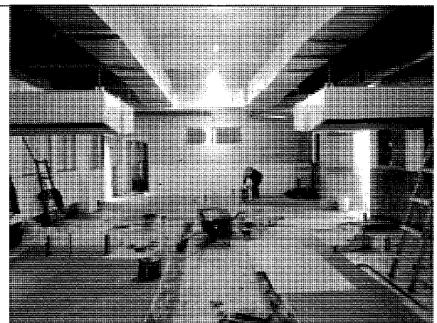
補風及油煙清淨系統風管配置
