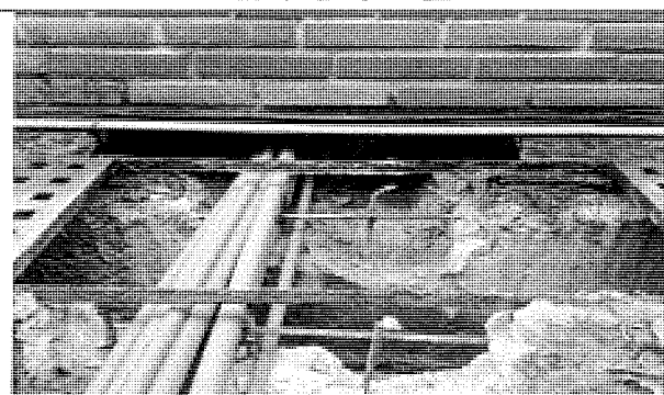
給排水(含熱水)及電源管線配置
