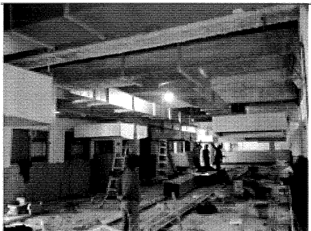
補風及油煙清淨系統風管配置
